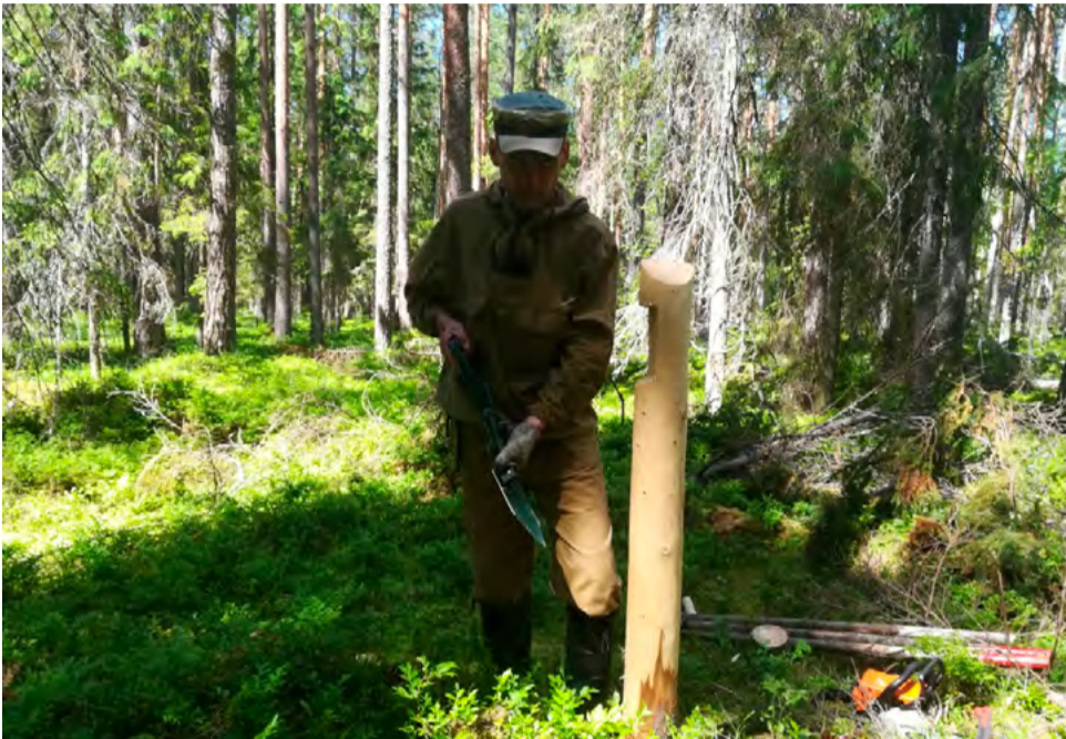
Установка углового столба
